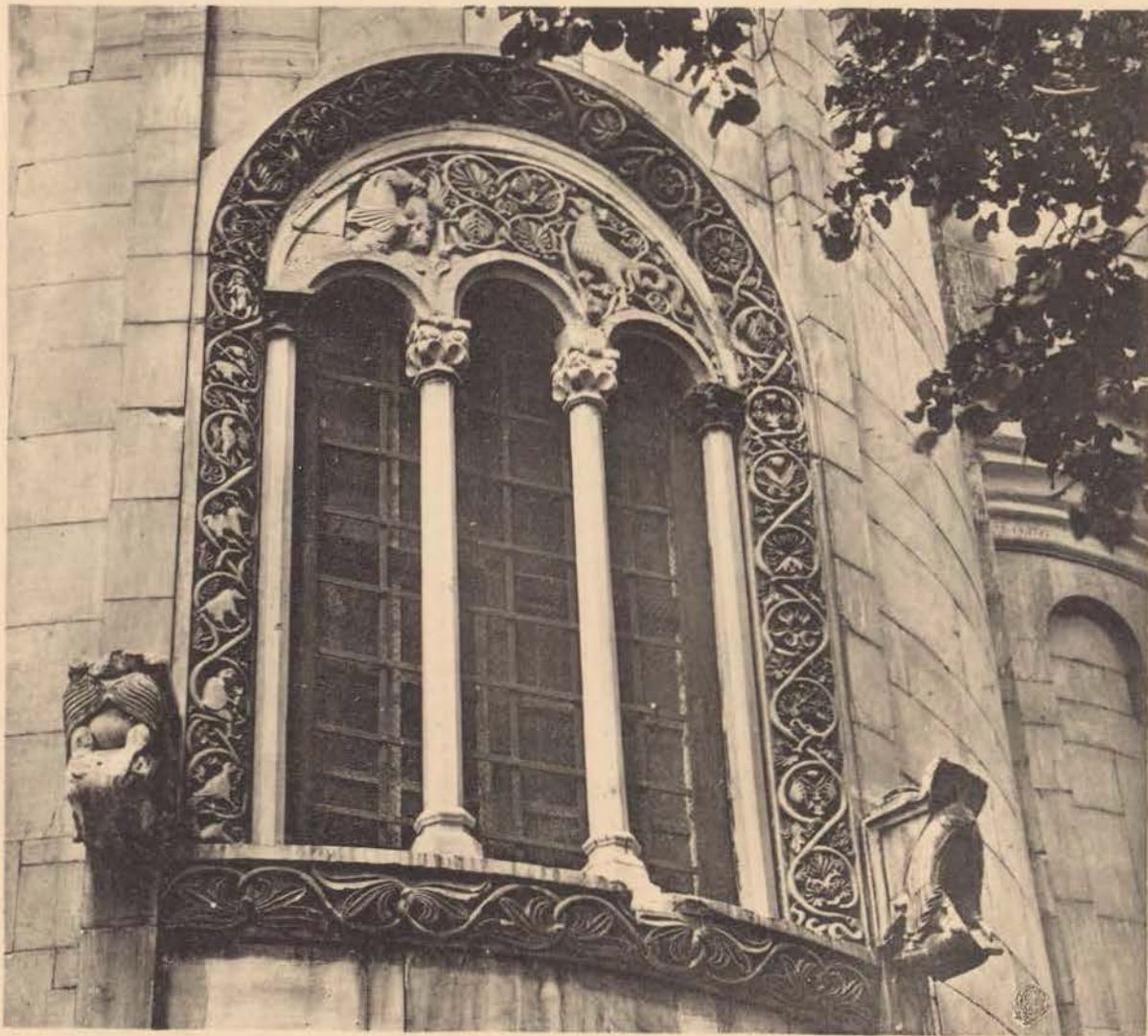
76. Eglise de Nemanja, à Studenica. Fenêtre de l'abside.
